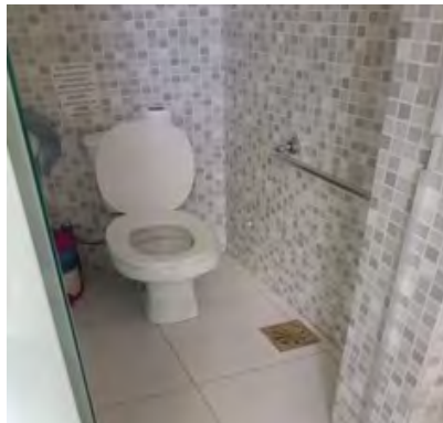
Figura 44- Sanitário acessível, Paróquia Nossa Senhora do Rosário
