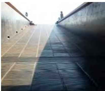
Figura 29. Visão interna da entrada principal - Catedral Nossa Senhora Aparecida
