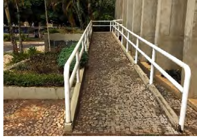
Figura 11- Rampa de acesso - Santuário Dom Bosco
