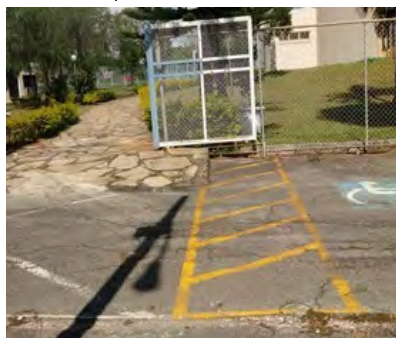
Figura 42- Rampa de acesso ao estacionamento - Paróquia Nossa Senhora do Rosário
