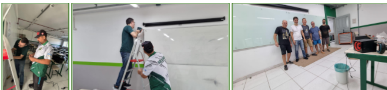
Imagem 13: Servidores e comunidade externa instalando quadros nas salas de aula
