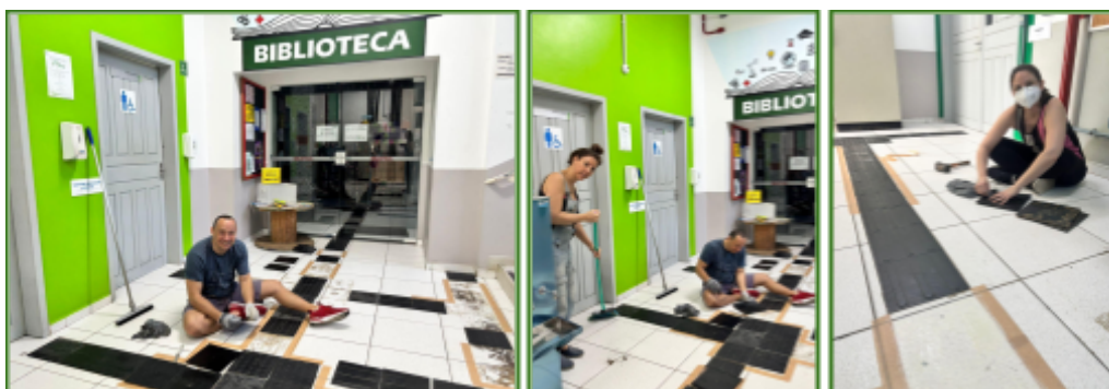
Imagem 11 Servidores atuando na colagem do piso tátil
